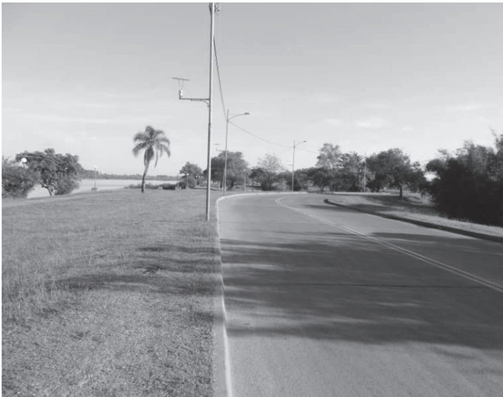
Costanera Norte en sitio de acceso al proyecto
