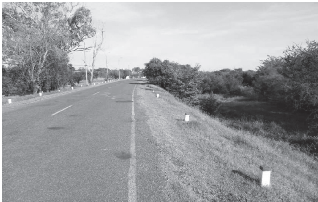
Vista de avenida Paraguay hacia el oeste en zona de implantación del proyecto
