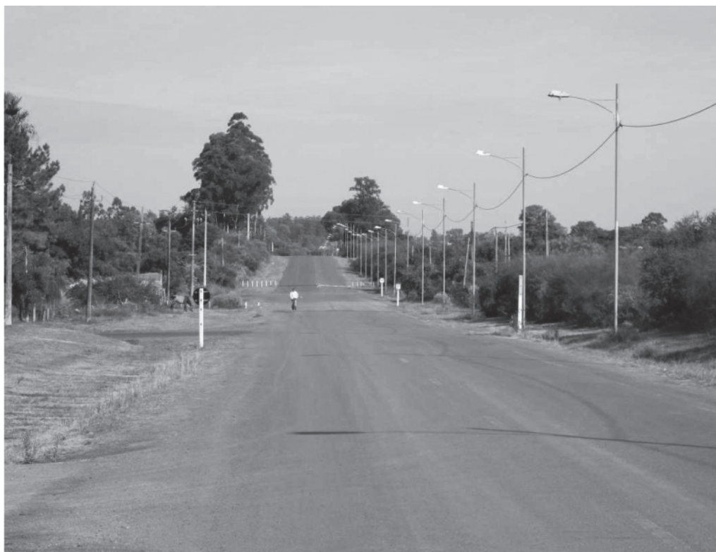
Vista de la avenida Apolón hacia el oeste
